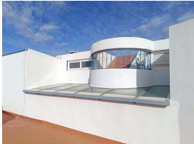
Colocación de barandillas en las claraboyas
